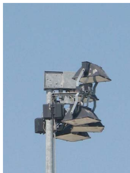
Foto: Impianto di illuminazione messo a norma
