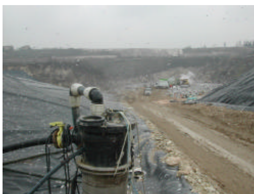
Foto 3: Settori in esercizio della discarica per rifiuti urbani di Pescantina
